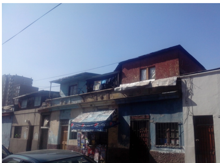
Ilustración 5. Condiciones de habitabilidad en sector Barrio 'La Chimba'. Se observa en su primera planta destinada a comercio y en segundo piso ampliaciones destinadas a cuartos presumiblemente para habitación / Fuente: Elaboración propia
