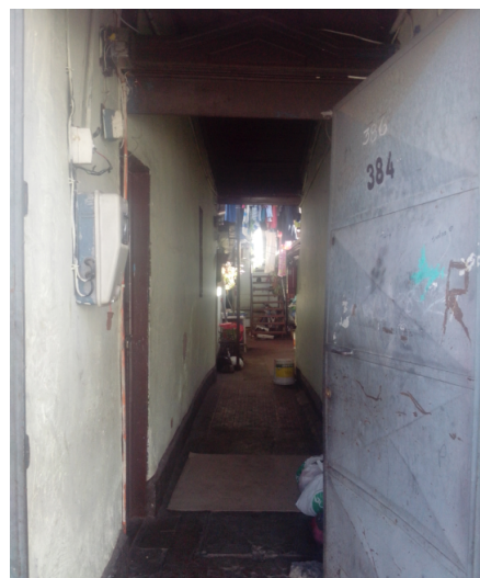
Ilustración 6. Interior de vivienda del sector Barrio 'La Chimba'. Se observa subdivisión de cuartos / Fuente: Elaboración propia
