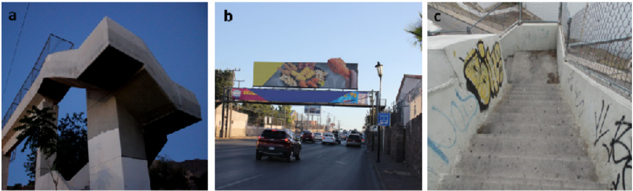
Figura 4. Condiciones físicas de puentes peatonales con respecto a alumbrado público, publicidad y mantenimiento. a) Puente CUU-07 sin alumbrado público, b) Puente CUU-21 con publicidad, c) Puente CUU-04 con presencia de orines y materia fecal.
