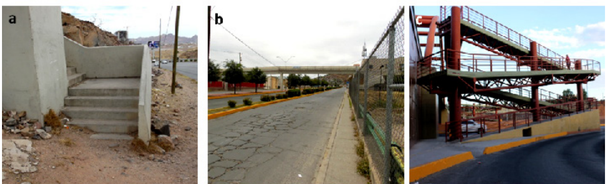
Figura 8. Condiciones de las banquetas adyacentes de los puentes peatonales en Chihuahua, México. a) Puentes CUU-10 sin acceso a banqueta. b) Puentes CUU-21 que cuenta con poco menos de un metro de banqueta. c) Banqueta adyacente del Puentes CUU-15 que cuenta con rampa de accesibilidad sin las dimensiones y ángulos adecuados y que da acceso al arroyo vehicular. Fuente: Elaboración propia.
