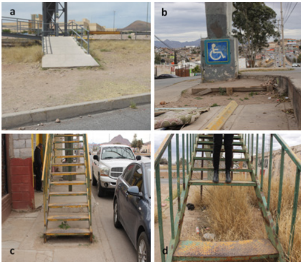
Figura 7. Condiciones de accesibilidad de puentes peatonales en Chihuahua, México. a) Puentes CUU-02 que cuenta con rampas de accesibilidad, pero no cuenta con banquetas. b) Puentes CUU-20 donde la banqueta no cuenta con rampa de accesibilidad. c) Puentes CUU-25 donde el acceso al puente obstruye la banqueta. d) Puentes CUU-26 que no cuenta con escalones. Fuente: Elaboración propia.
