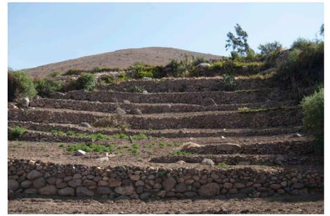
Figura 4. Socoroma. El trabajo comunitario a través del uso de piedra apilada en seco permitió el modelado de las laderas para reducir la pendiente y controlar la cantidad y velocidad de agua que escurre para el riego. (2017)
