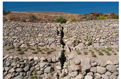
Figura 5. Socoroma. Vista frontal de una “*Jalanta*”, un canal de riego que permite la distribución por gravedad en forma secuencial entre cada una de las terrazas de cultivo. (2017)
