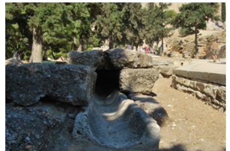
Figura 2. Canal de conducción de aguas en Acrópolis de Atenas. Forma parte del conjunto de canales para recuperar el agua lluvia y conducirla a cisternas (2013)
