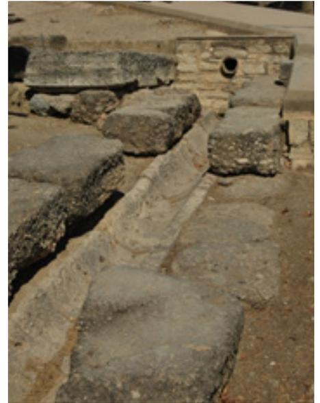
Figura 1. Canal de drenaje en Acrópolis de Atenas. Los excedentes de agua infiltran por gravedad desde las zonas altas para conducirlos hacia zonas bajas para su uso en riego (2013).
