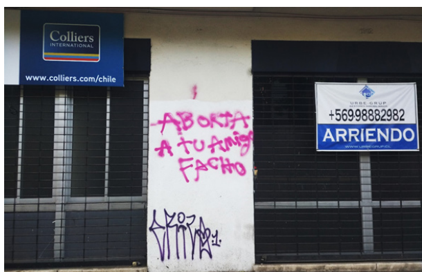
Imagen 7. Rayados sobre fachada, en Calle Grajales con Vergara, Barrio República Fuente: Elaboración propia
