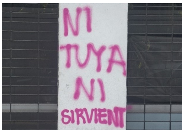
Imagen 8. Rayados sobre fachada, en Calle Grajales con Vergara, Barrio República Fuente: Elaboración propia
